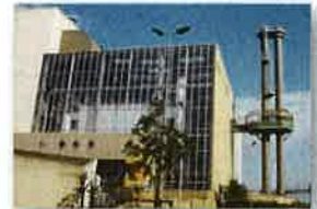
Unité de Valorisation Énergétique d'Hagani à Metz (UVE)
